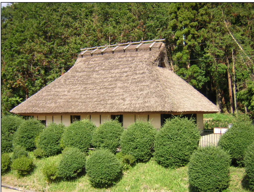
南側からの建物全景
