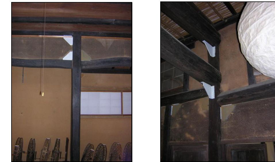
仕口ダンパーの取り付け (豊田市田舎家)
