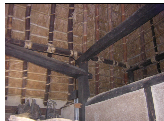
横架材端部の納まり
