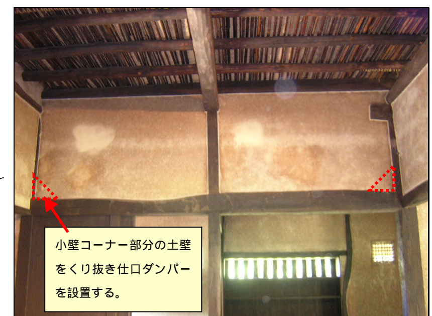
仕口ダンパーの設置
