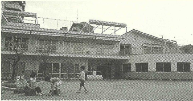
西側玄関と事務室 (R部分)
