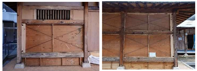
図 4 対象建物外観写真（補強後）
