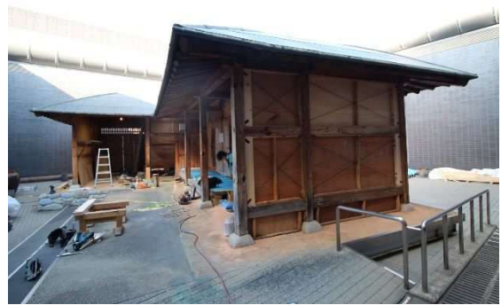
図 3 対象建物外観写真（補強後）
