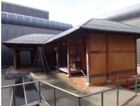
図 1 対象建物外観写真（補強前）
