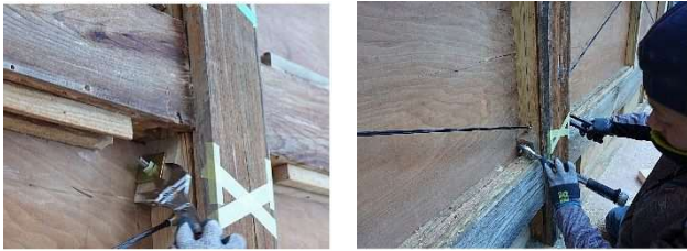
図5 締め付けトルク管理
