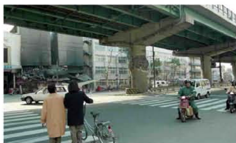
神戸デパート近くの阪神 高速道路橋脚
