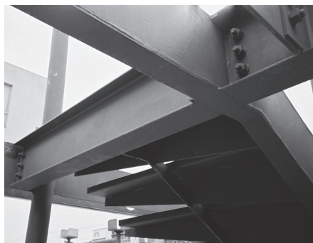
写真 4 ササラ桁と直交小梁の接合部
