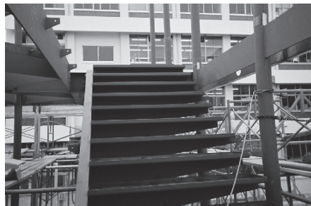
写真 3 ササラ桁と段部
