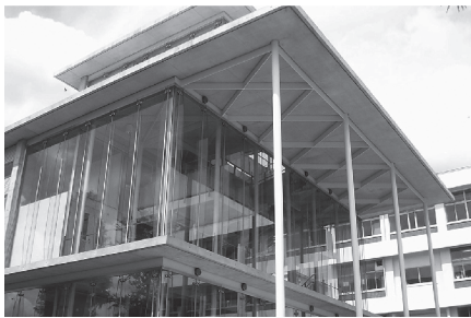
写真 1 建物外観 (東側)
